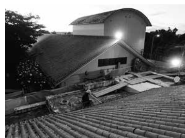
屋根の補修の様子
